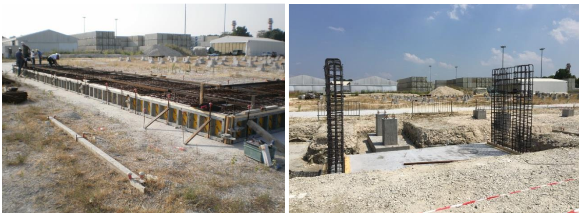
Foto: cantiere nuova torcia
